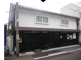
町家外観修景整備の事例(H27)
