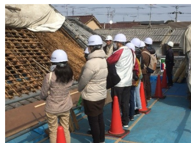
修理中の現場公開の様子 H30.2
