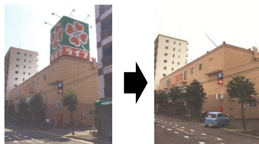
屋上広告物撤去事例（H29）
