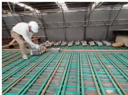
記名瓦を葺いている様子
