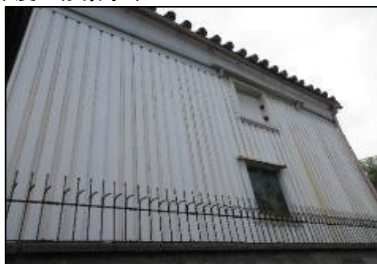
(改修前) 撮影日：令和2年9月12日
