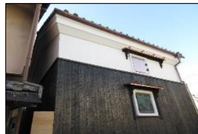
(改修後) 撮影日：令和3年1月21日
