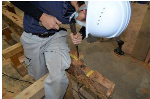
柱根継の加工風景 (令和2年11月27日撮影)
