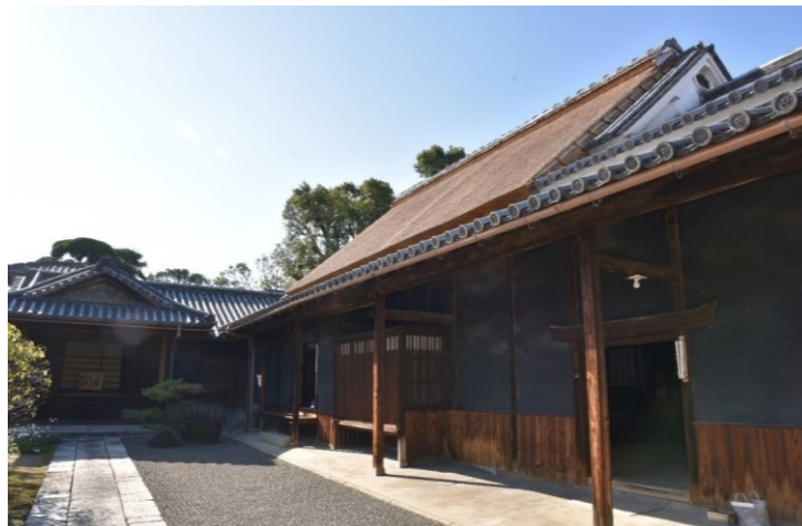
高林家住宅主屋竣工全景
