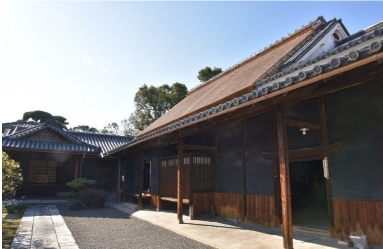
高林家住宅主屋竣工全景
