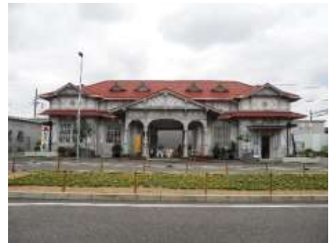
浜寺公園駅駅舎
