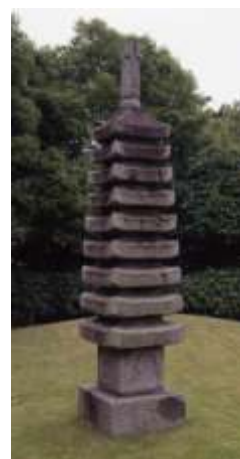
旧浄土寺九重塔
