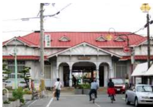
南海電気鉄道 浜寺公園駅
