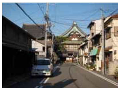
電線類による景観阻害
