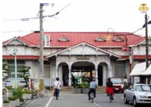
南海電気鉄道 浜寺公園駅
