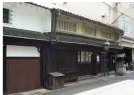
刃物製造所の建造物
