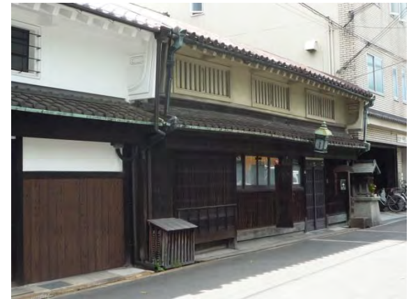
刃物製造所の建造物
