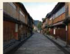
電柱電線類移設等による魅力的なまちづくりの推進
