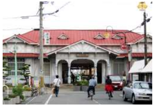
現在の浜寺公園駅駅舎
