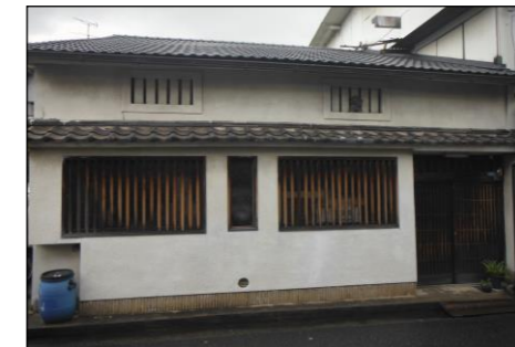
施工内容:(腰板、格子)焼杉板、格子新設(ベンガラ塗料)、(ゴミ箱)焼杉板内に収納
