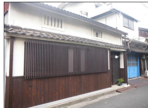
施工内容:(腰板、格子)焼杉板、格子新設(ベンガラ塗料)、(ゴミ箱)焼杉板内に収納
