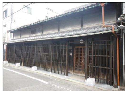
施工内容:(駒寄、腰壁)部分修繕、(樋)付替え(銅製)、(土間)洗い出し仕上げ 等
