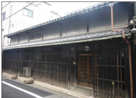
施工内容:(駒寄、腰壁)部分修繕、(樋)付替え(銅製)、(土間)洗い出し仕上げ 等
