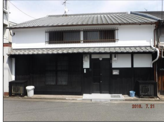
施工内容:(外壁)漆喰風塗装、(室外機等)目隠し格子設置 等
