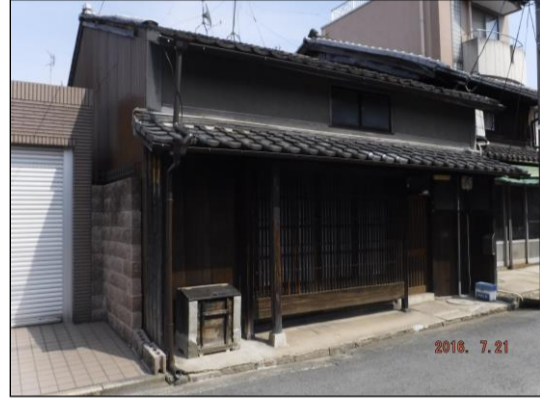
施工内容:(格子)部分修繕及び古色塗り、(腰壁)焼杉板張替 等
