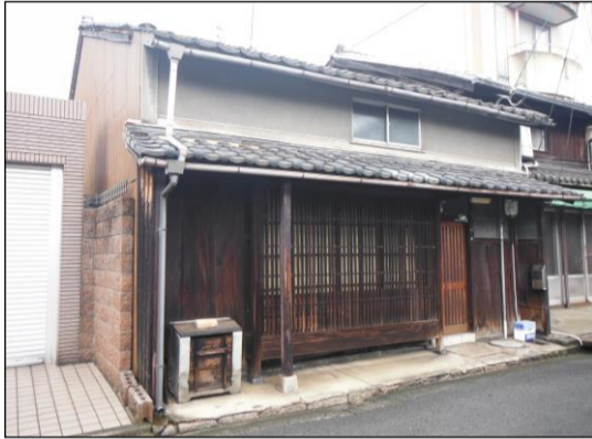
施工内容:(格子)部分修繕及び古色塗り、(腰壁)焼杉板張替 等
