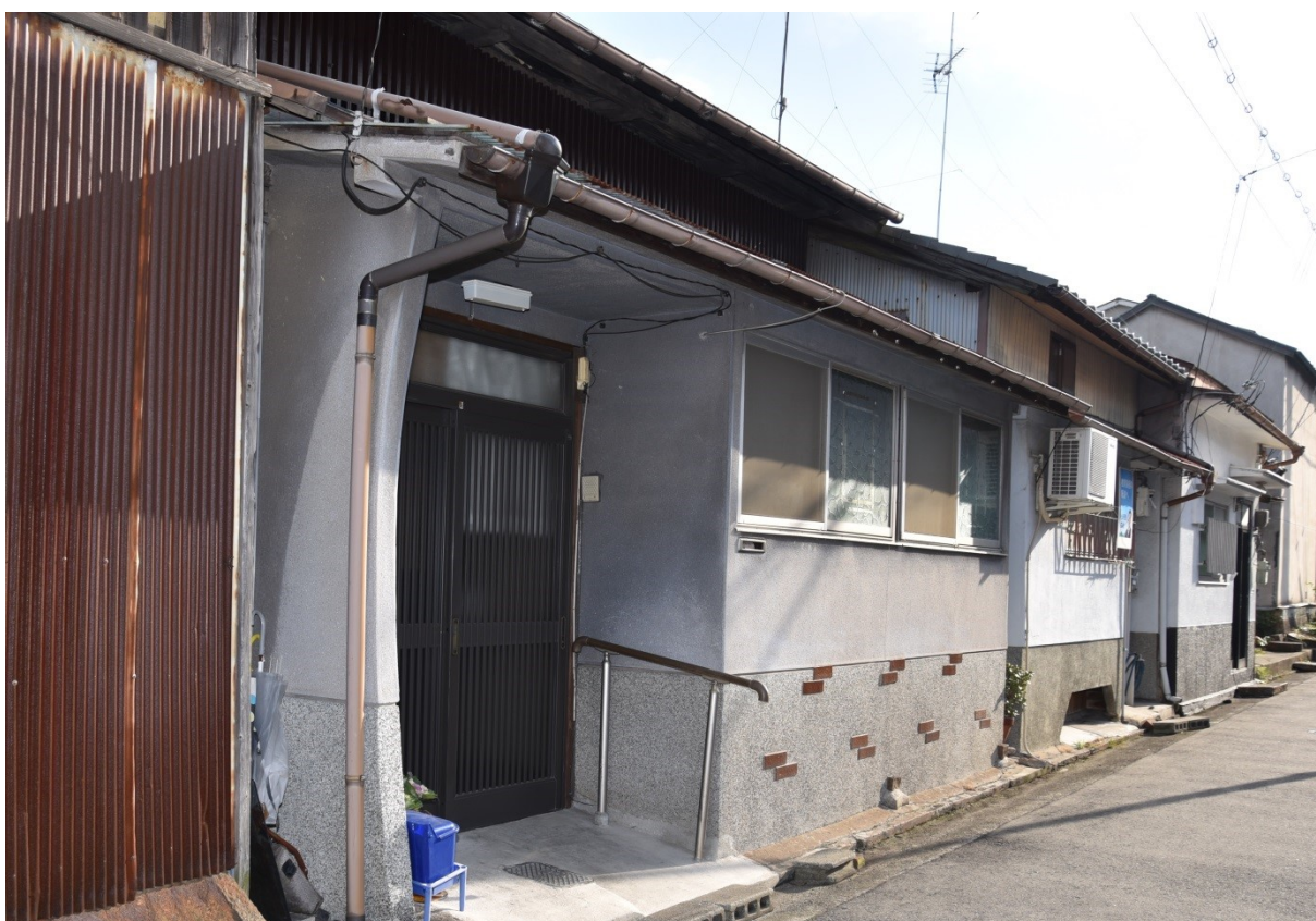
附属棟 正面 北より
