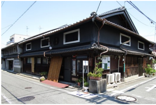
施工内容：（外壁）腰板取替・土壁補修・漆喰塗り、（建築設備）移設の上 目隠し格子設置、（庇）補強・修繕
