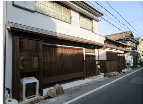
施工内容：（外壁）漆喰風塗装、焼杉板張り、（開口部）木製面格子、木製引違戸新調 等
