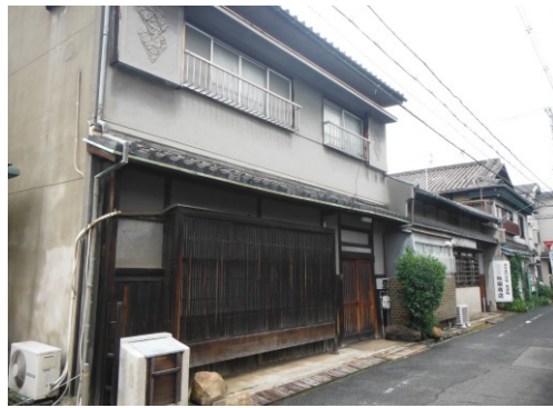
施工内容：（外壁）漆喰風塗装、焼杉板張り、（開口部）木製面格子、木製引違戸新調 等
