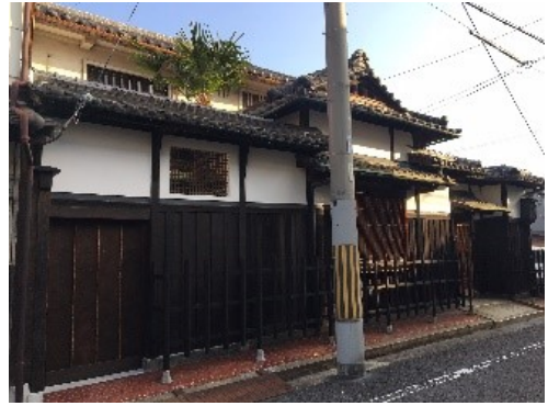
施工内容：（開口部）：シャッター撤去、（外壁）焼杉板張り補修、本漆喰塗り 等
