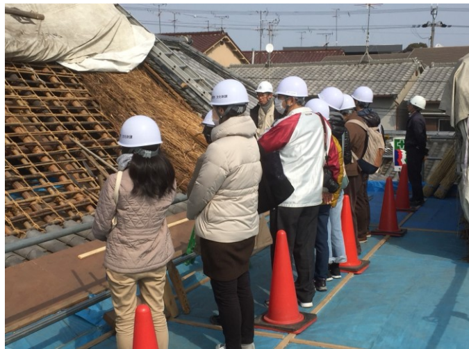
修理中の現場公開の様子
