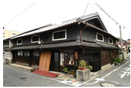
施工内容：（外壁）腰板取替・土壁補修・漆喰塗り、（建築設備）移設の上 目隠し格子設置、（庇）補強・修繕
