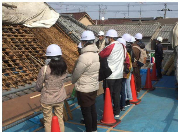
修理中の現場公開の様子
