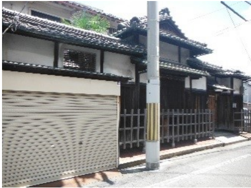
施工内容：（開口部）：シャッター撤去、（外壁）焼杉板張り補修、本漆喰塗り 等
