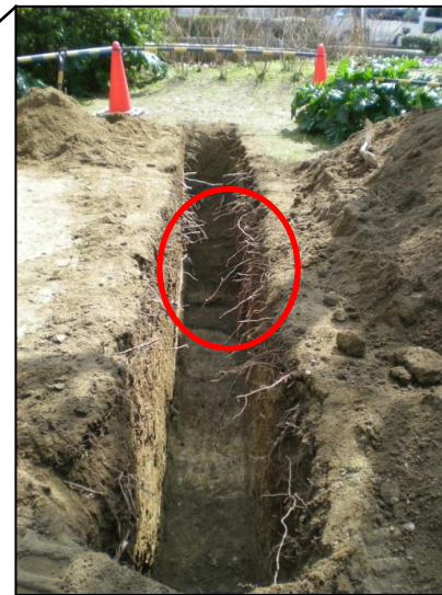
■試掘状況写真
