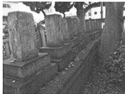
樹根による台石組の傾き
