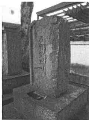
墓石の表面剥離・剥落が進行
