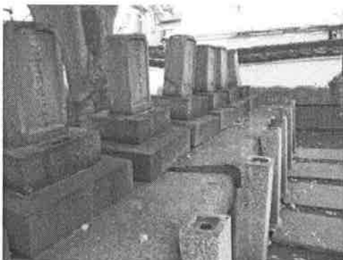
樹根による墓石の傾き
