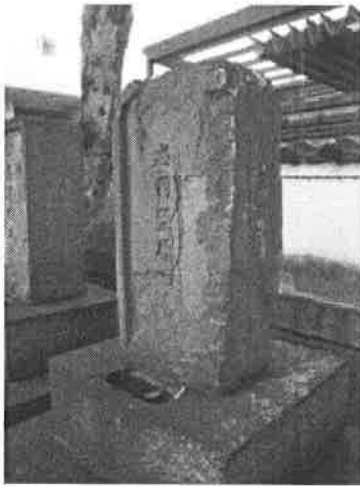
墓石の表面剥離・剥落が進行
