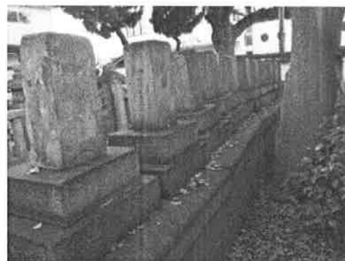
樹根による台石組の傾き
