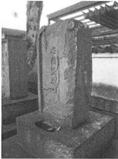
墓石の表面剥離・剥落
