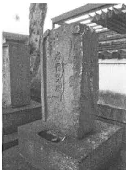
墓石の表面剥離・剥落
