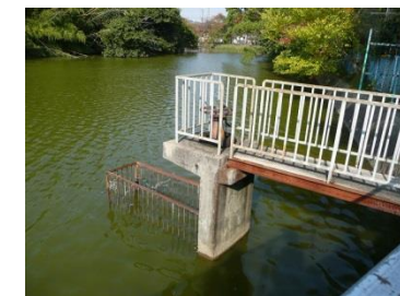
2箇所に設置された樋(写真は東側)
