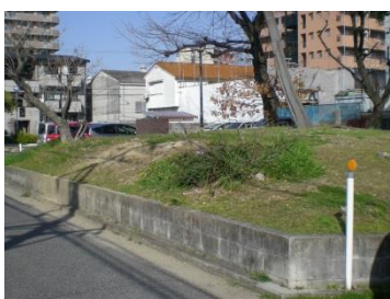
道路際の擁壁と土留めブロック
