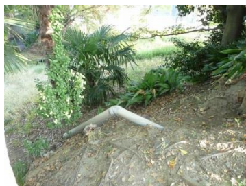
露出した配管
