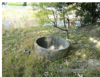
前方部上のコンクリート構造物
