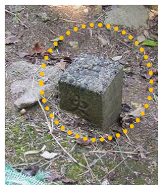
埋没している境界杭
