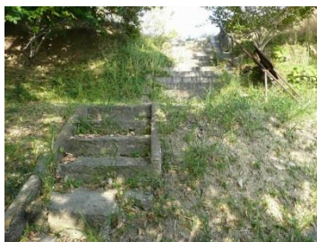
墳丘に設置された階段
