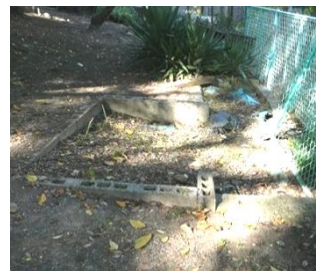
コンクリート構造物
