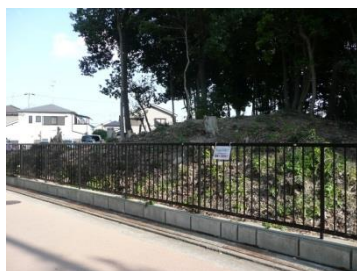
フェンス・擁壁
