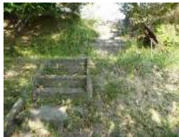
墳丘に設置された階段
