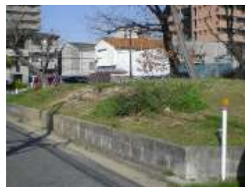
道路際の擁壁と土留めブロック
