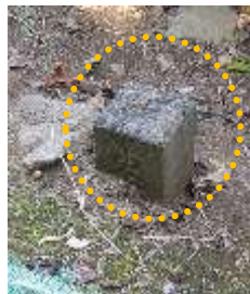
埋没している境界杭
