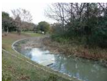
間知石で整備された護岸
