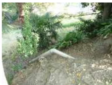
露出した配管
