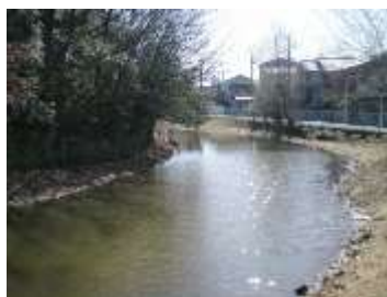
滞水により生じた浸食
