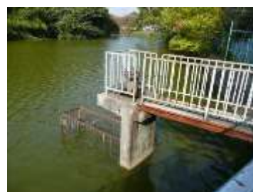
2箇所を設置された樋(写真は東側)
