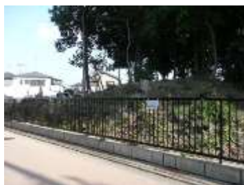
フェンス・擁壁
