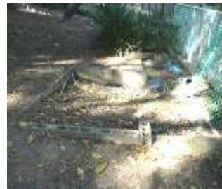
コンクリート構造物
