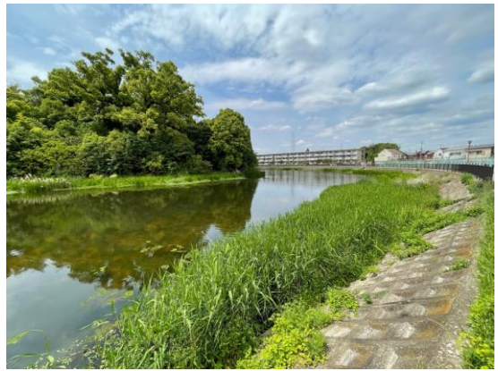
陸地化が進んでいる様子
