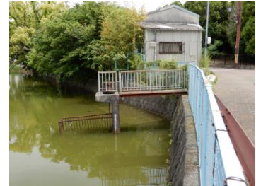
2箇所を設置された樋 (写真は東側)
