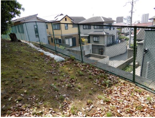
改修した古墳北側のネットフェンス
