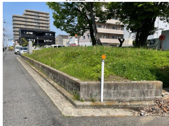
道路際の擁壁と土留めブロック
