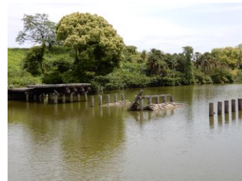
開発時に架けられた橋の残骸
