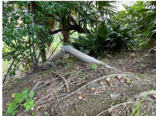
露出した配管
