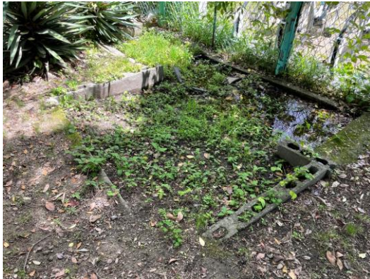
コンクリート構造物
