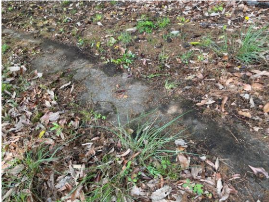
コンクリート構造物
