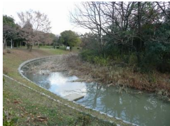
間知石で整備された護岸
