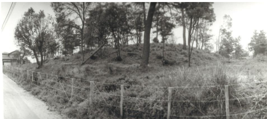
昭和40年代 頃の古墳近景（南東から）
