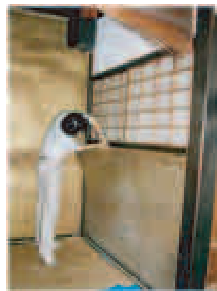
解体（壁貼付のはがし）
